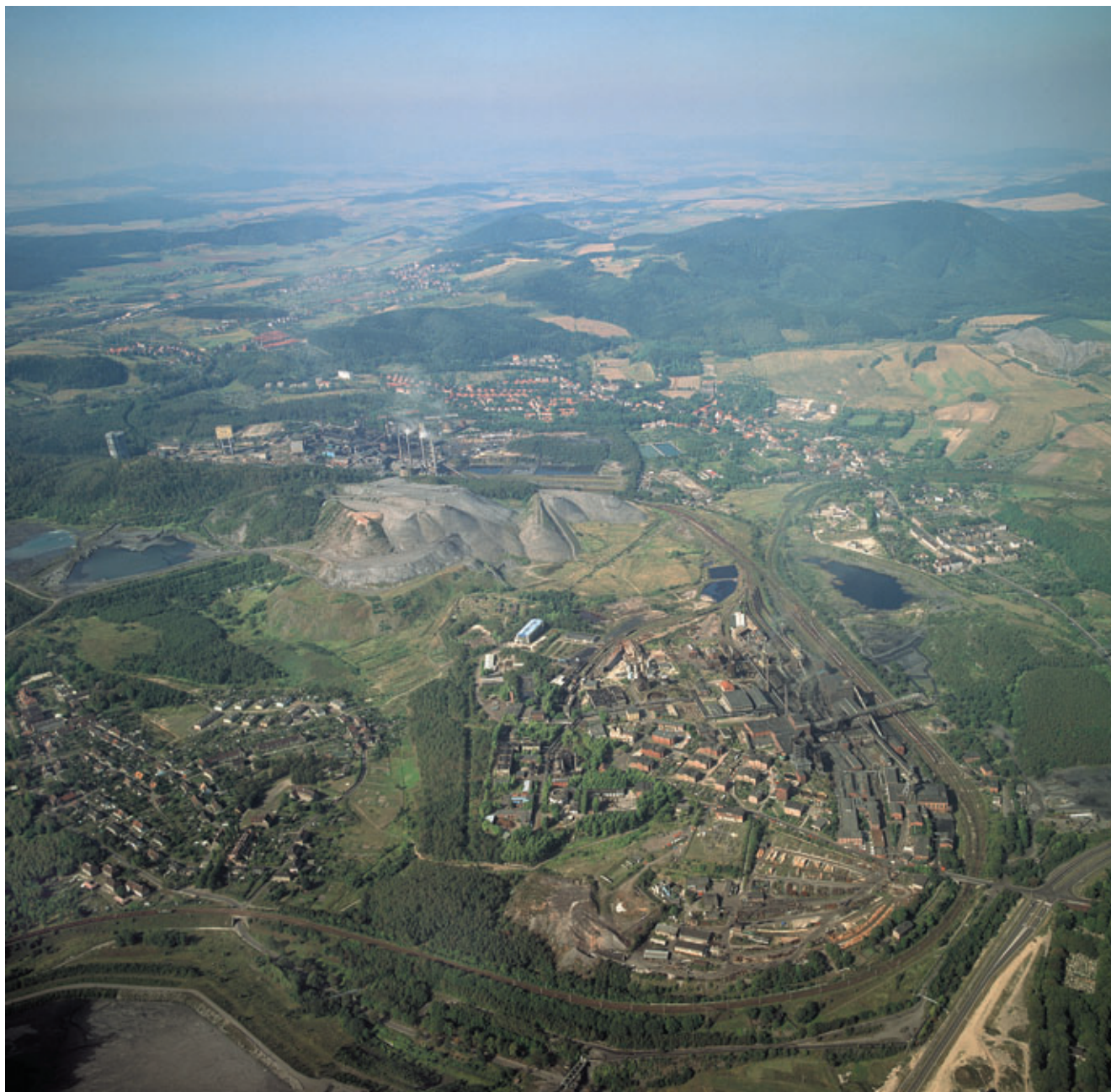
Ryc. 54. Ziemia Wałbrzyska (11.2.1). Wałbrzych. Mozaika terenów przemysłowych, kopalnianych i zabudowy mieszkaniowej oraz terenów rolniczych i leśnych. Fot. M.Ostrowski.
