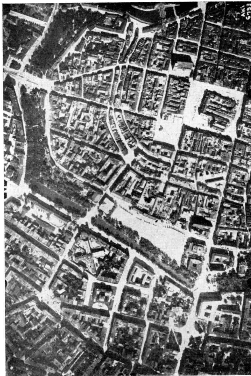
Fot. 2. Dawny przebieg podwójnej linii fos przy ul. Podwale i Złote Koło oraz ul. Świdnicka (VIII 1929 rok)
